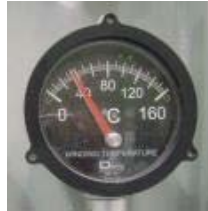
Fig. 5.3 Indicador de Temperatura de Devanado
