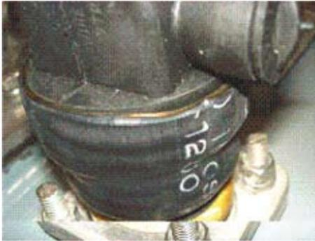
Figura 3. Unión de conector muelleboquilla de baja tensión.
