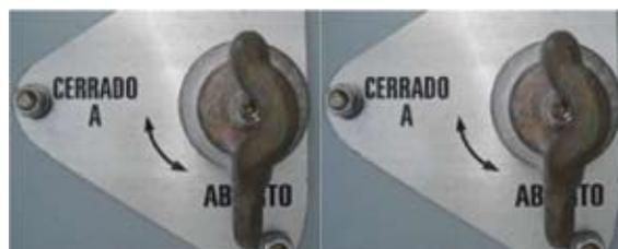
Figura 3. Arreglo de seccionadores de 2 posiciones para conexión anillo.
