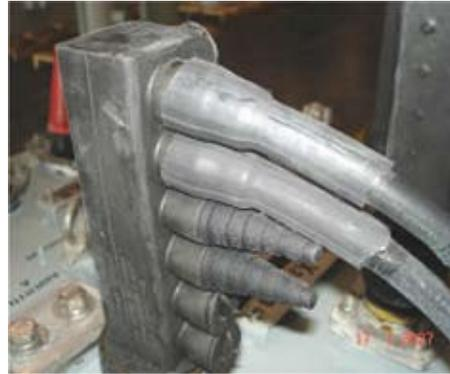
Figura 4. Unión de cable de baja tensión conector muelle.
